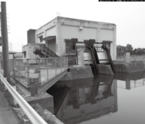
普段のポンプ場の全景
