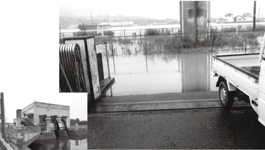
浸水寸前のポンプ場
