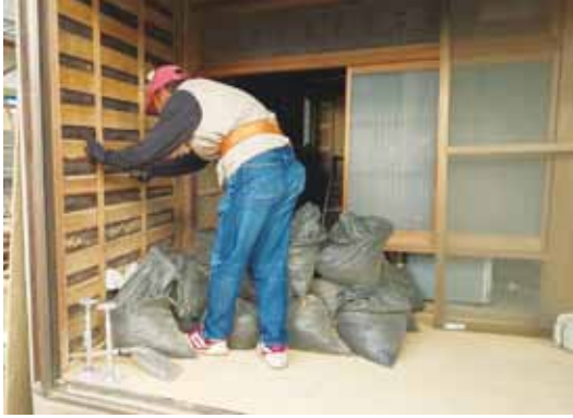
▲住宅の壁の取り壊しや床の張替えなど、「チーム山本」の支援活動の幅はとても広いのが特徴です。
